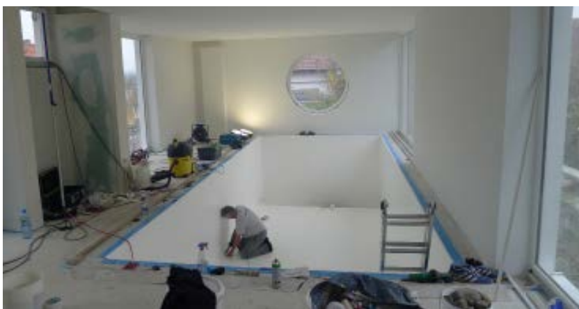
Oben: Wohnzimmeratmosphäre: Die Schwimmhalle lädt zum längeren Aufenthalt ein. Unten: Das Betonbecken wurde mit einer weißen Folie ausgekleidet.
