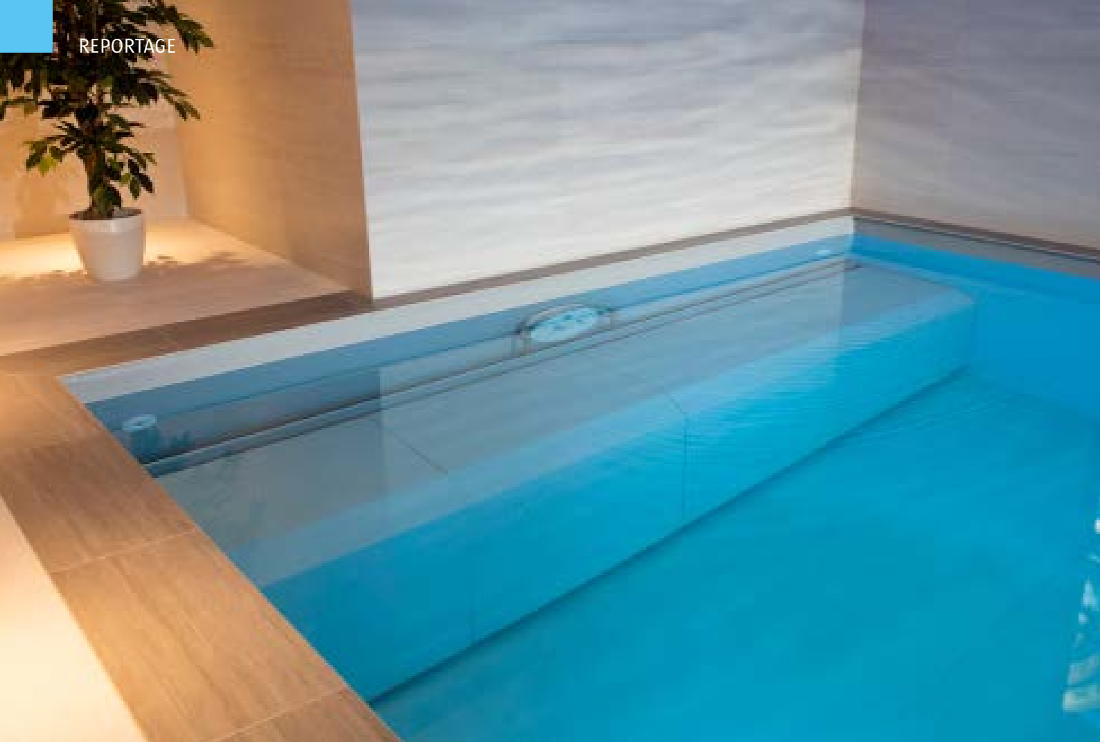
Oben: Die Abdeckung verbirgt sich unter einem Kasten im Becken. Darüber wurde die Gegenstromanlage eingebaut. Unten: Die markante Einstiegstreppe mit langgezogener erster Stufe.
