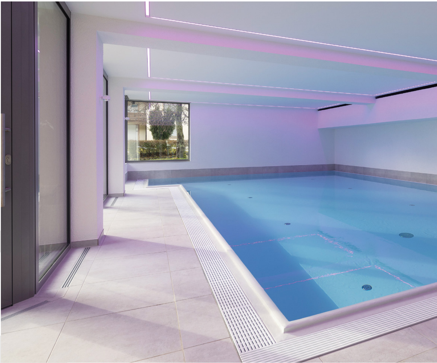
Geradlinig in der Gestaltung und mit ausreichend Tageslicht versorgt, ist die Schwimmhalle des Landhotels Wittstaig. Die hellen, großformatigen Fliesen fügen sich optisch ideal ins Gesamtbild ein.
