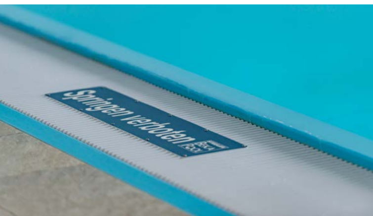
Überlaufrinne des Schulschwimbeckens.
