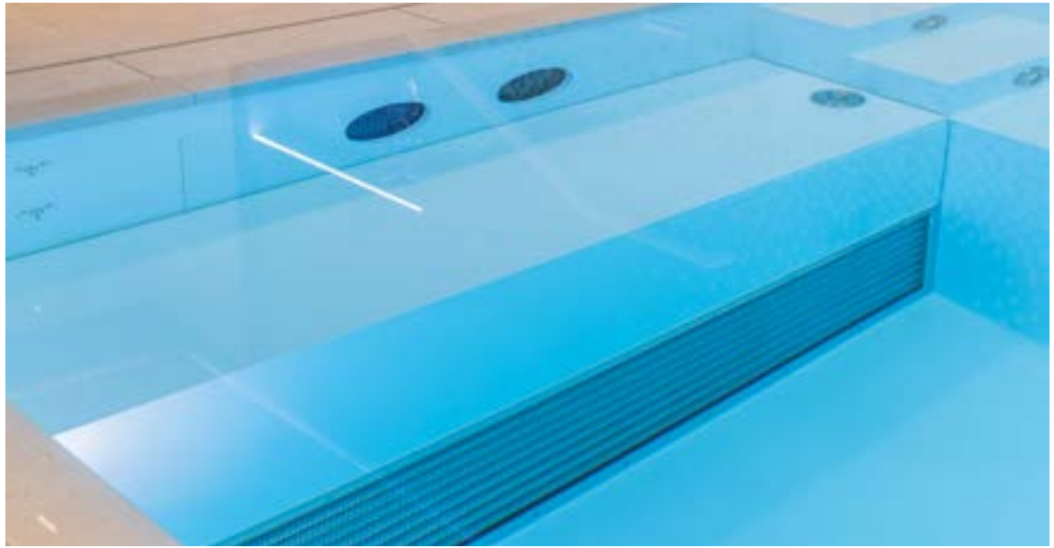
Dieses Bild zeigt die Lüftungsschienen am Übergang vom Halleninneren zur Dachterrasse. Eine Entfeuchtungsanlage sorgt für gutes Klima und verhindert das Beschlagen der Glasscheiben.
