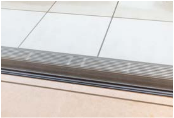
Dieses Bild zeigt die Lüftungsschienen am Übergang vom Halleninneren zur Dachterrasse. Eine Entfeuchtungsanlage sorgt für gutes Klima und verhindert das Beschlagen der Glasscheiben.
