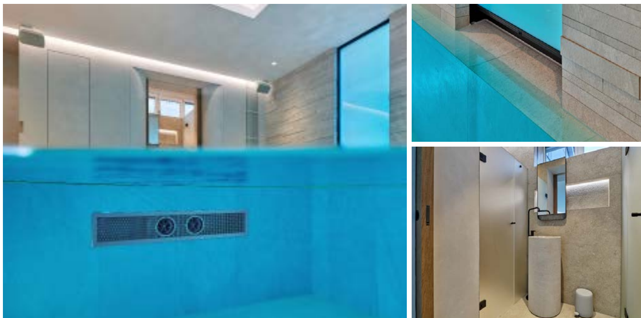
Links: Die Ospa-Gegenstromanlage im Becken. Rechts oben: Das Wasser reicht bis an die Lichtnischen heran. Die Nischen sind aber dicht, wie Tests ergaben. Rechts unten: Eine Dusche wurde ebenfalls in die Schwimmhalle integriert.
