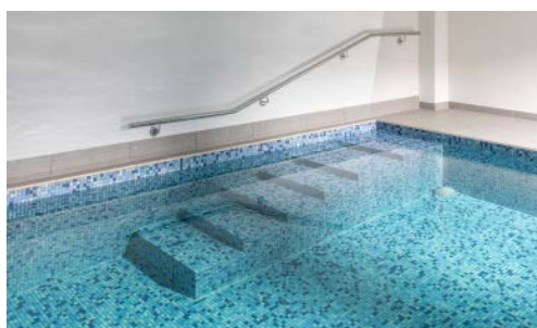
Links: Das Mosaikbecken wurde komplett saniert und mit neuen Mosaiken ausgekleidet. Rechts: Die Dusche in der Schwimmhalle. Eine Sauna und der Aufenthaltsbereich blieben erhalten und sind klimatechnisch von der Schwimmhalle abgetrennt.
