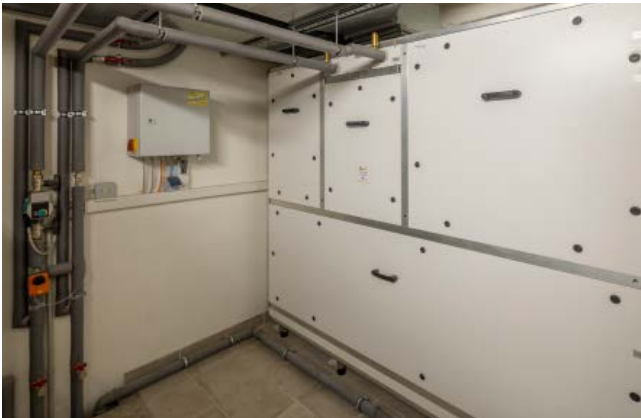
Das Lüftungs- und Entfeuchtungsgerät von enkho im Technikraum.
