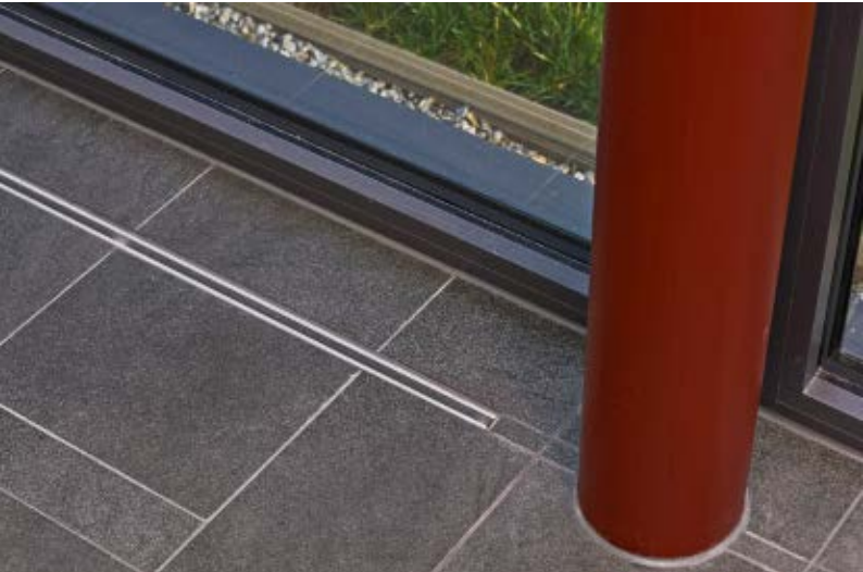
Oben: Große Glasscheiben eröffnen den freien Blick in den Garten. Links Mitte: Die Gegenstromanlage. Links unten: Schlitzschienen an den Fenstern halten die Scheiben beschlagfrei. Rechts: Dank der auskragenden Einstiegstreppe geht keine Schwimmfläche verloren.
