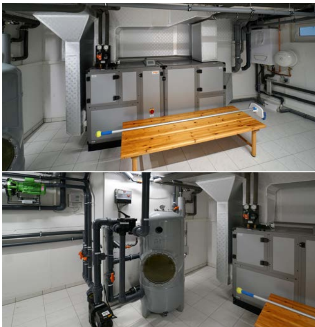
Im Untergeschoss der Schwimmhalle und direkt am Becken sind die sopra-Schwimmbadtechnik und die Lüftungstechnik untergebracht.
