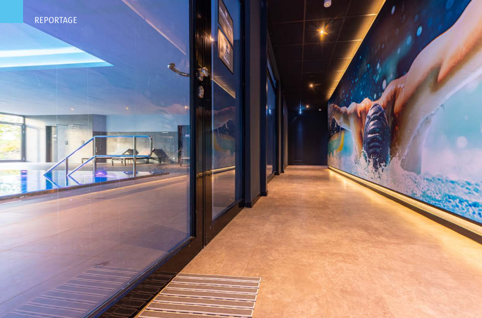
Oben: Wandelgang um die Schwimmhalle. Links Mitte: Der Deckenbereich über dem Pool wird von einer Lichtvoute eingefasst. Links unten: Lüftungsschienen an der Decke. Rechts unten: Die Auskleidung der Schwimmhalle mit ISO-Plus-Wärmedämmung und Dampfsperre.
