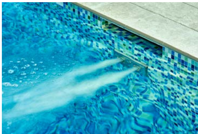
Links: Die KLAFS-Sauna im Untergeschoss des Neubaus. Rechts: Gegenstromanlage in der Beckenwand.
