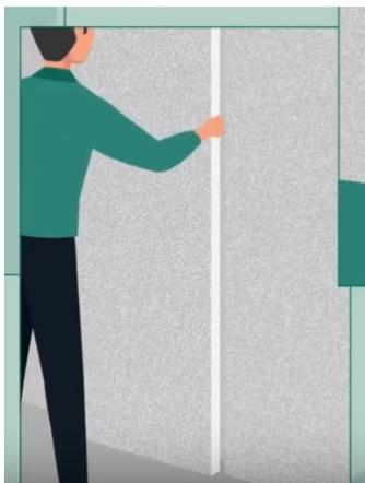
Die ISO-PLUS-ELEMENTE Typ III werden mit ISO-Baukleber verklebt.
