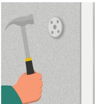
Zusätzlich werden ISO-Feuchtraumdübel gesetzt. Im Wandbereich erleichtert dies die Herstellung einer planebenen Fläche. An der Decke ersparen die ISO-Feuchtraumdübel das Abstützen der Elemente. Dies wäre so lange notwendig, bis der Baukleber abgebunden hat.
