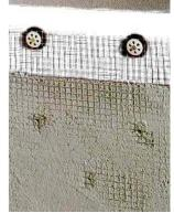
Tragputz Z3 mit 1,5 bis 2 cm dick aufgebracht und lotund fluchtgerecht verzogen. Nach dem Ansteifen wird die Oberfläche mit einem Gitterrabot für die nachträgliche Verklebung aufgeraut. Das Metallgitter samt Dübelköpfe sind komplett überdeckt. Die gesamte Putzscheibe ist sicher bis zum Rohboden zu führen.
