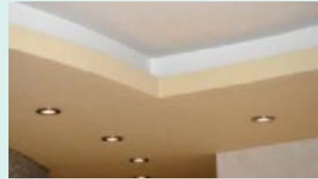
Elegante Lichtvoute und Downlights als Verkleidung eines Trägers bzw. Lüftungskanals.
