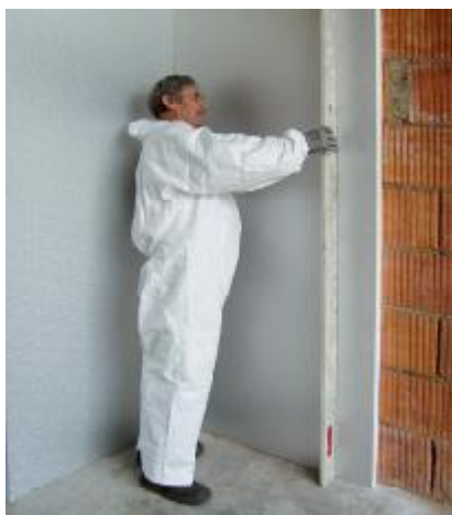
Rationelle Montage von Wärmedämmung und Dampfsperre in einem Arbeitsgang.
