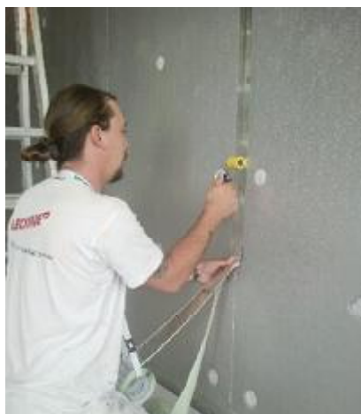
Alle Anschlüsse und Fugen werden zuverlässig abgeklebt. Die System-Dübel sind dicht verklebt.
